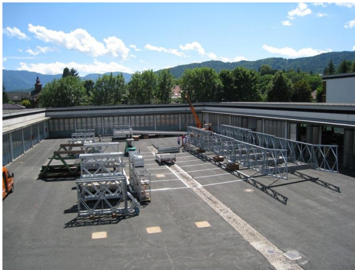
Ein Teil des fast fertiggestellten Ausstellungsgeländes im Straßenbauamt Villach
